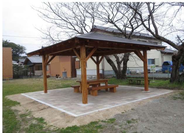
王中島地区工事
